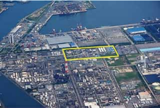
コンビナート内の四日市工場
