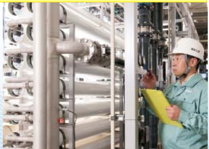
水処理装置のメンテナンス
