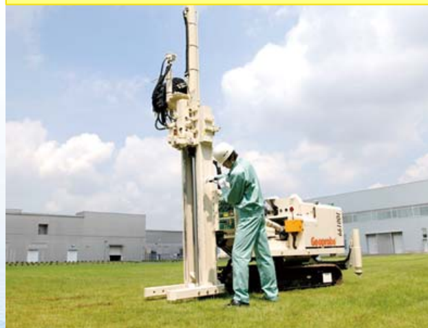
土壌・地下水浄化
