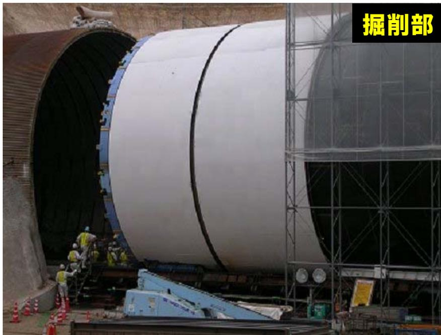
推進掘削機(直径12m)
