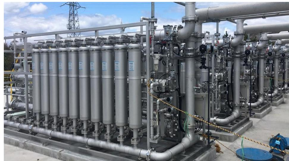
砂ろ過の代替設備として、GL膜の膜ろ過設備を採用 事業所内の用水/飲料水などを製造
