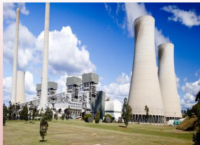
石炭火力発電所
